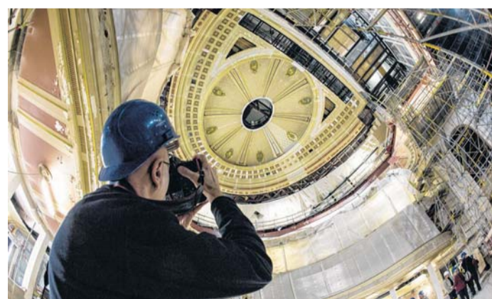
Die restaurierte Saaldecke der Berliner Staatsoper ist bereits fertig. Viele andere Stellen aber nicht.
